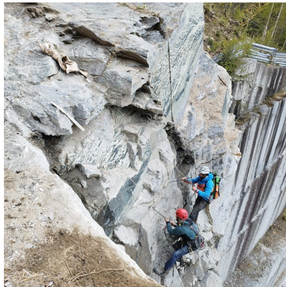
FOTO N 1 E 2 – ULTERIORI INTERVENTI DI DISGAGGIO IN CORSO DI ESECUZIONE
