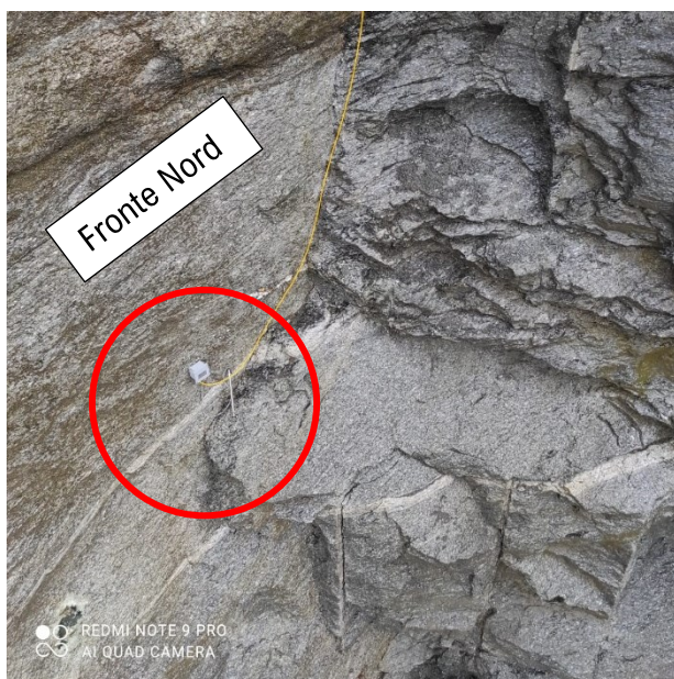
FOTO N 3 E 4 – I DUE FESSURIMETRI INSTALLATI SULLE FRATTURE CHE DELIMITANO LATERALMENTE (FRONTE N E FRONTE EST) LA PORZIONE DI AMMASSO DA MONITORARE
