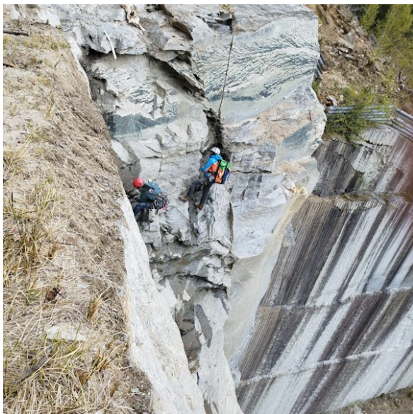
FOTO N 1 E 2 – ULTERIORI INTERVENTI DI DISGAGGIO IN CORSO DI ESECUZIONE
